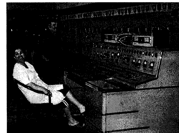
Kontrollraum im Sender Flaka
